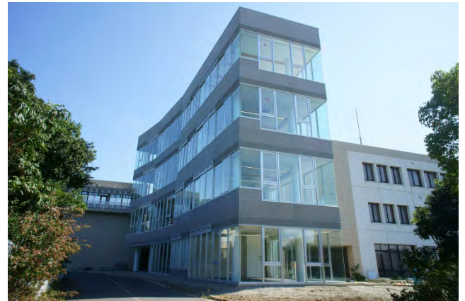
クロスカルセンター構想実現に向けて整備が進む図書館増築棟
